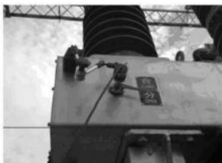
35KV/SF6 开关传感器安装
